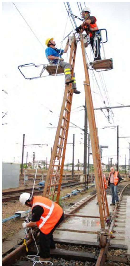
ÉCHELLE POUR LIGNE À HAUTEUR CONSTANTE TYPE RATP, TGV, EXISTE AUSSI SANS BARRE DE POUSSÉE.
